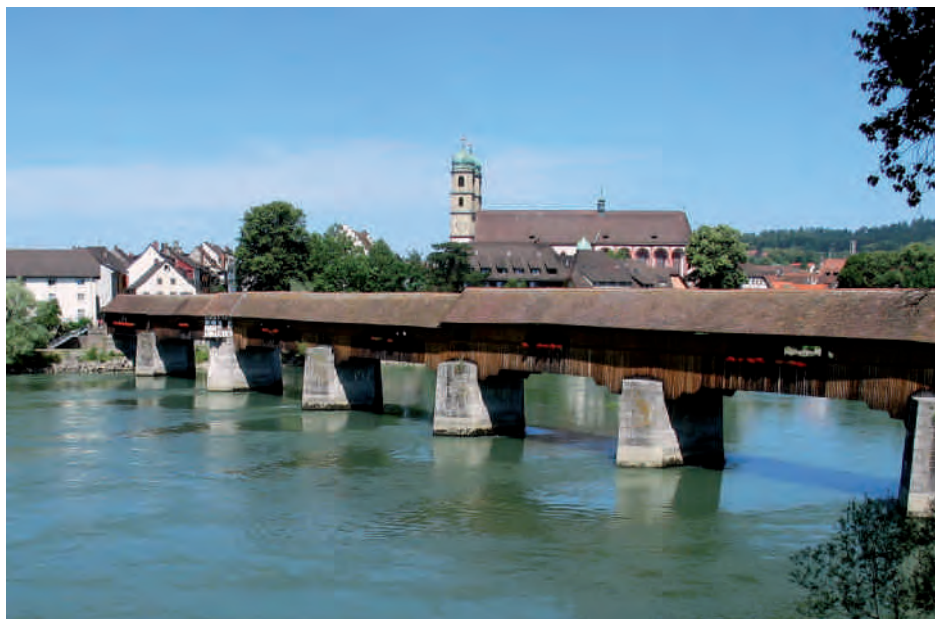
Holzbrücke Bad Säckingen
